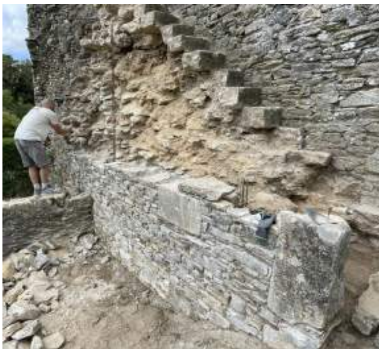
Remontage de l'escalier de la tour © SAS Gibaud
